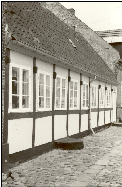
Torvet 20. Præstø's ældste hus – opført i 1744 til skomager Michael Salomon Larsen. Facaden er stadig den oprindelige.
