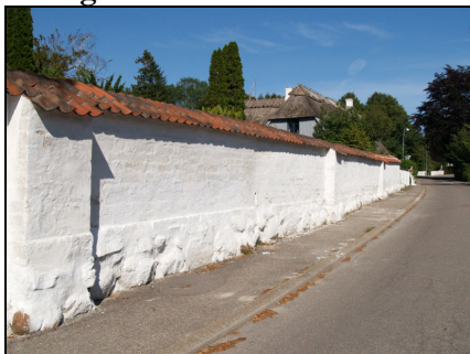
Muren efter reparation
